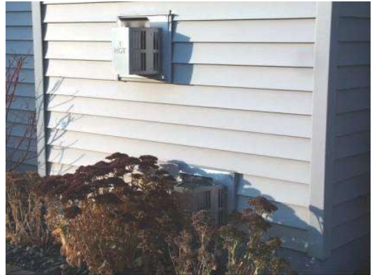
2. Ventilación de la chimenea a 12 pulgadas del suelo. (ver especificaciones del fabricante para otros)
