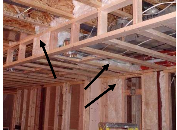
6. Aislamiento de fibra de vidrio utilizado como bloqueo contra el fuego cada 10 pies horizontalmente en el soffito y separando el soffito de la cavidad de la pared
